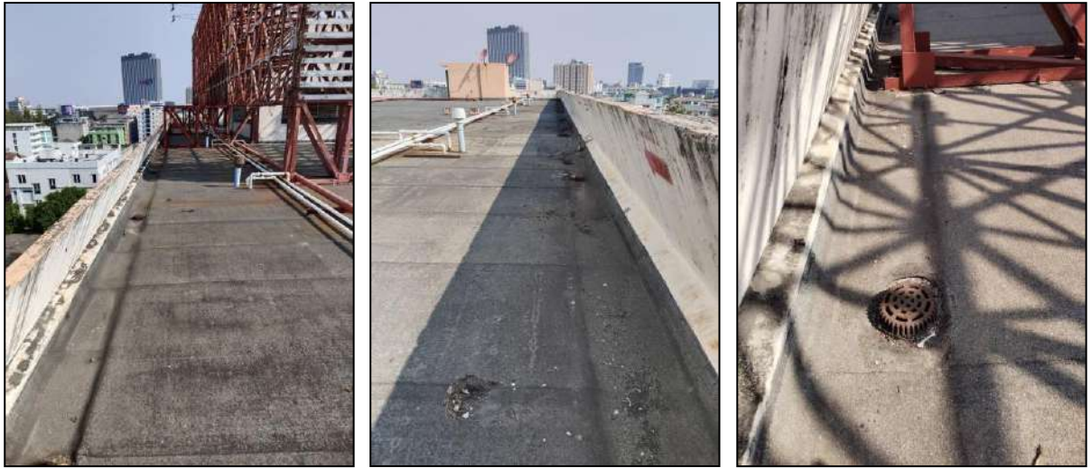
รูปที่ 2-14 รางระบายน้ำรอบอาคารบริเวณชั้นดาดฟ้า
