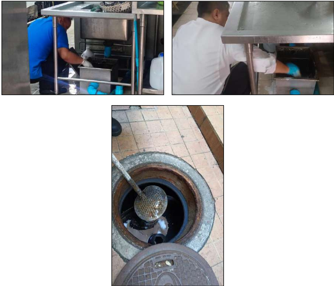
รูปที่ 2-10 การดูแล บำรุงรักษา และสูบตะกอนออกจากระบบบำบัดน้ำเสีย
